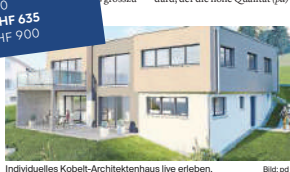
Individuelles Kobelt-Architektenhaus live erleben. Bild: pd
